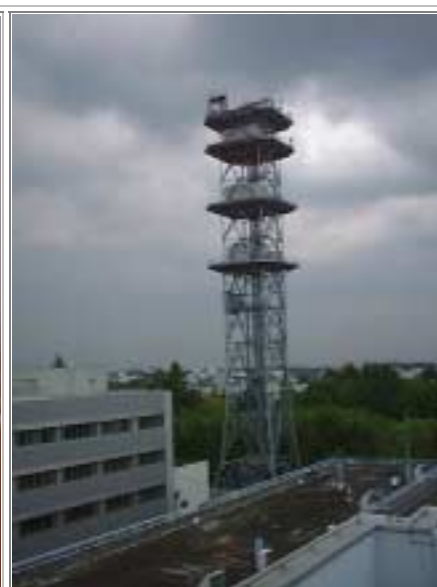
図7 レピータを設置した鉄塔 (地上高 60mH)
